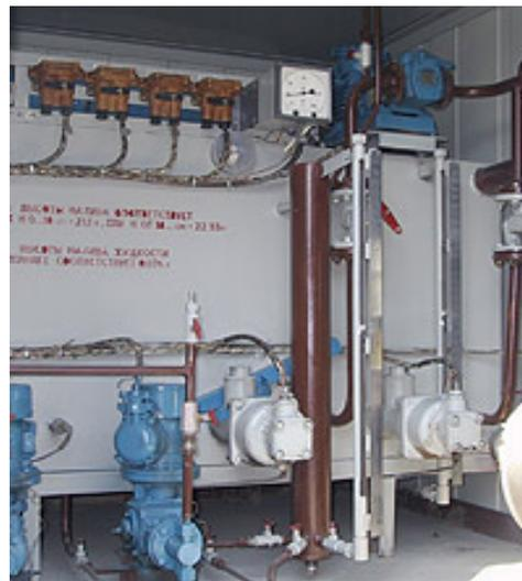
Оборудование БДР размещается в технологическом блочно-модульном помещении взрывозащищенного исполнения.
